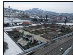
平成24年3月(杭打設)
