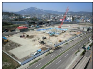
平成24年4月(杭打設)
