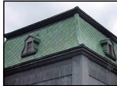
ドーマーの事例
